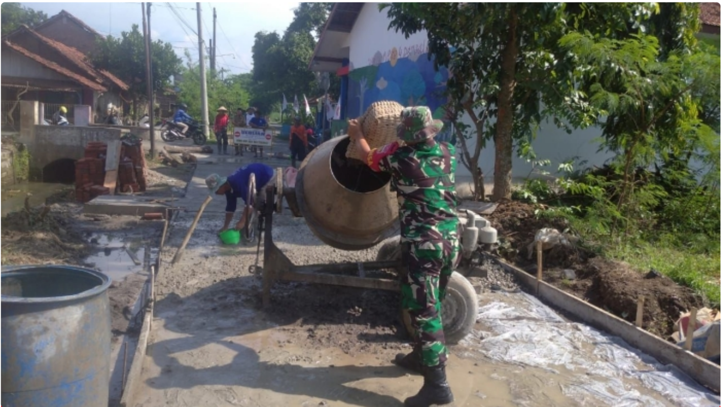
(Foto Istimewa) Pengecoran Jalan Di Dukuh Kepyar
